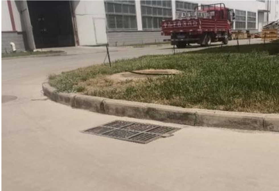
图 6 本项目废水处理措施
